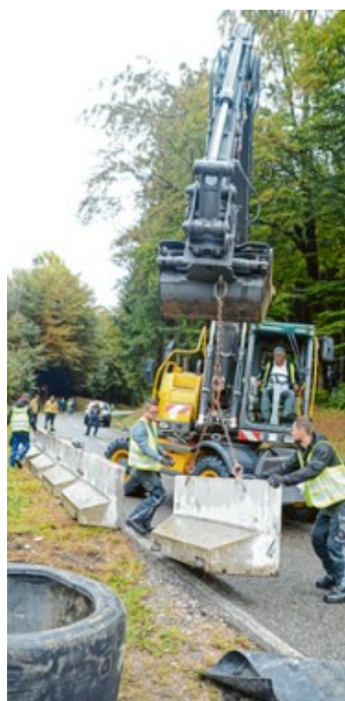
Massenhaft tonnenschwere Betonblöcke wurden für die Sicherheit aller verbaut.
